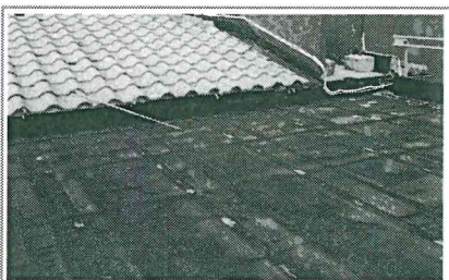
foto 5: ripristino impermeabilizzazione copertura
